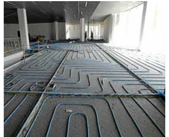
Instalación de la calefacción radiante. FOTOS: G. MESTRE
