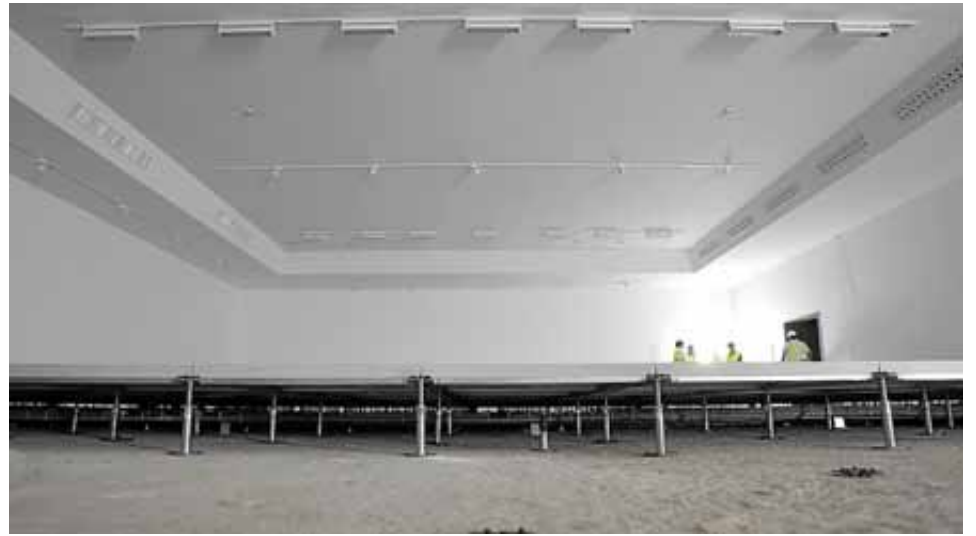
Instalación del suelo técnico en una de las salas de exposiciones.
